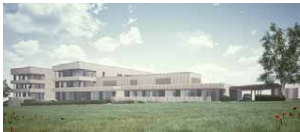
Projet Heisdorf II - Coeba Architectes
