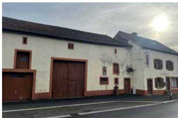
Bâtiment dans l'état actuel
