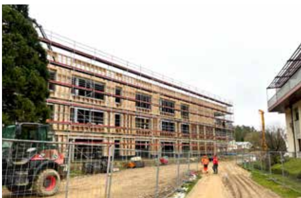
Chantier Heisdorf II
