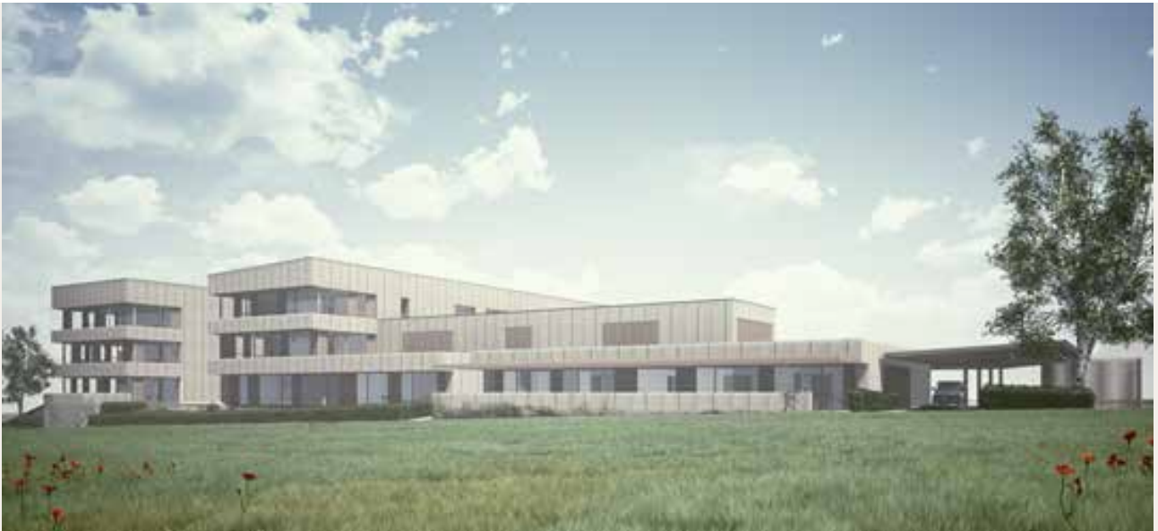
Projets Heisdorf 2 - Coeba Architectes
